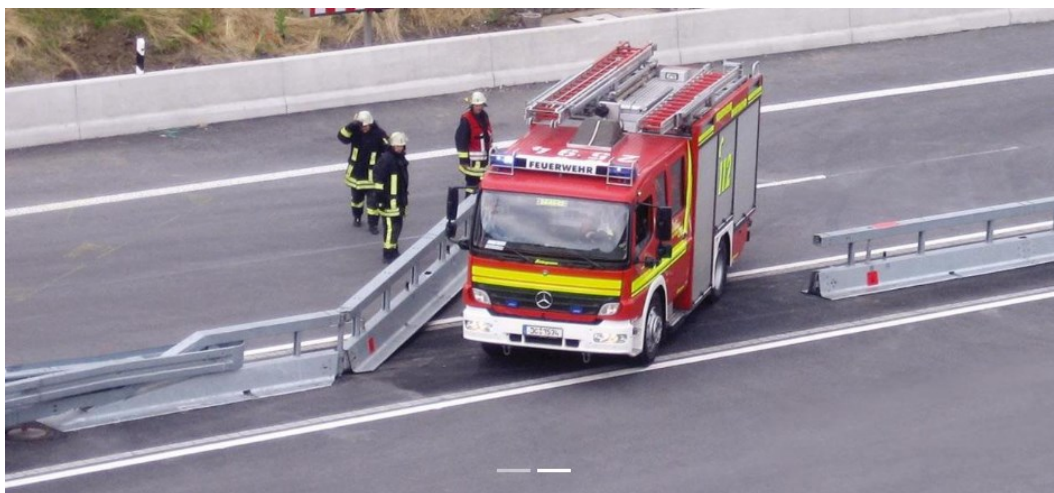
Obrázok 22: Pohľad na zvodidlo Gate-Guard QC
